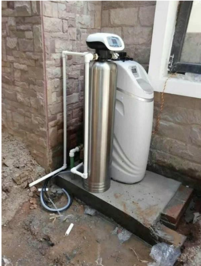
前置过滤器和净水机器直接连接上现有管道即可。
